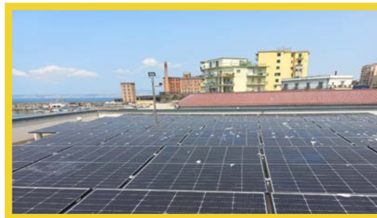
Installazione pannelli fotovoltaici Torre del Greco - Via Spiaggia del Fronte
